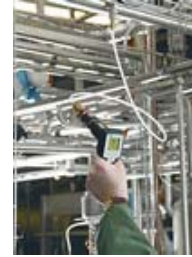
使用 DP300 监控管道 气体干燥程度
